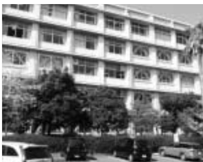
耐震化改修済みの校舎
