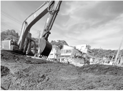
八幡野漁港でのしゅんせつ作業風景
