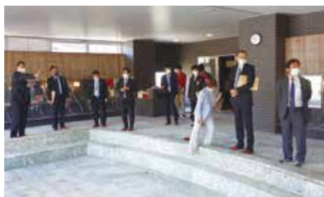
改修前の選手宿舍大浴場の現状を確認した
