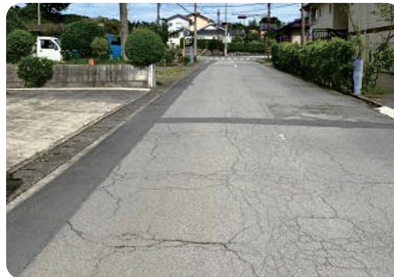
合同点検により抽出された整備箇所
