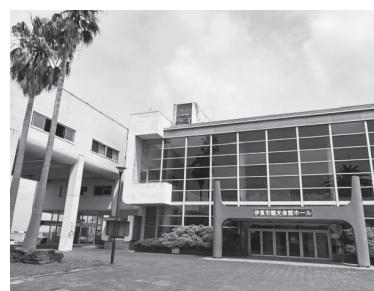
建設から60年以上が経過した観光会館
