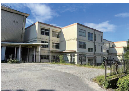
舗装整備工事を実施する伊東小学校前駐車場
