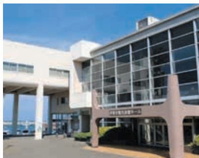
老朽化が進む観光会館
