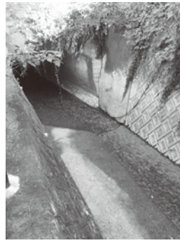
八幡野川（国道下の暗渠部分）
