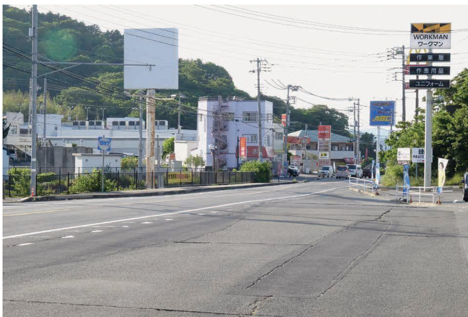
国道135号一碧湖入り口付近（ワークマン付近） 平成29年
