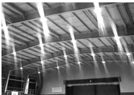
屋内運動場の照明をLED照明へ交換
