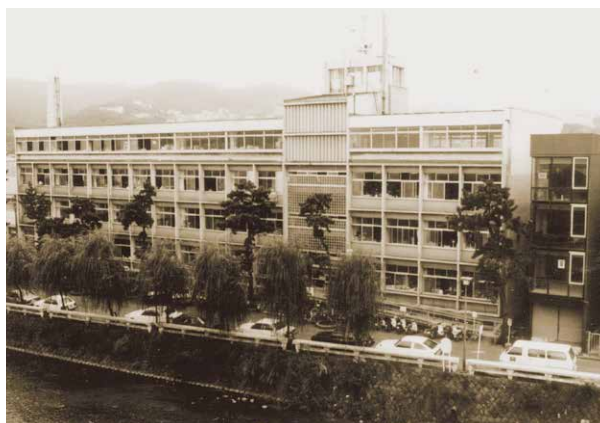
旧 市役所庁舎（松川側）（市政の概要 昭和56年版掲載）
