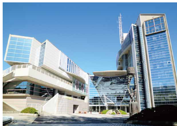
現 市役所庁舎（市議会だより平成24年11月号掲載）
