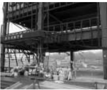
津波により職員等が犠牲となった 南三陸町防災対策庁舎
