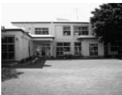
耐震性貯水槽が設置される市立南幼稚園
