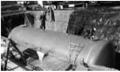
耐震性防火水槽 (タンク据えつけ現場)
