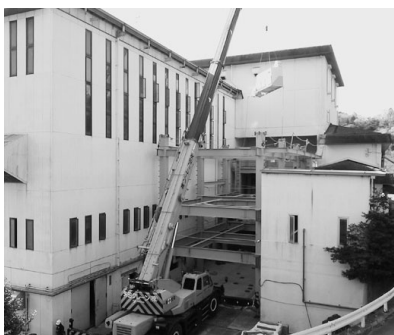
更新改良整備中の環境美化センター
