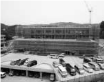
新市民病院建設現場
