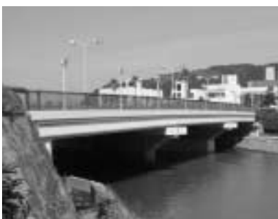
耐震補強工事が予定されている渚橋
