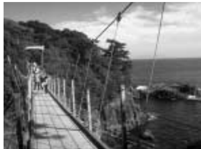
城ヶ崎橋立吊橋
