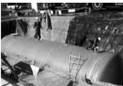
耐震性防火水槽（タンク据えつけ現場）
