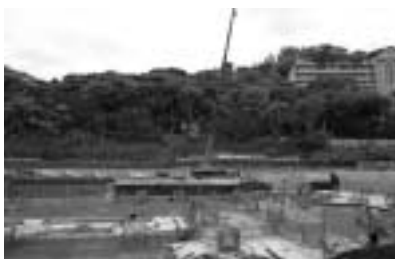
新市民病院建設現場
