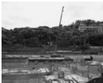
新病院建設現場
