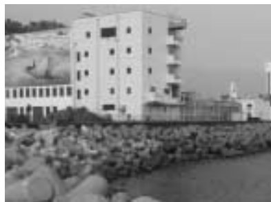
湯川終末処理場前の消波ブロック
