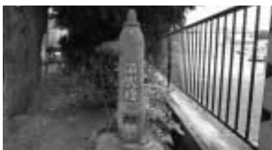
消火栓（地上式）
