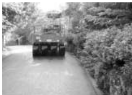
地域応急処理事業の原材料支給で整備した道路
