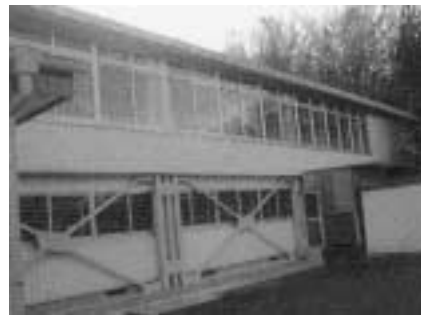
耐震化工事が完了した大池小体育館
