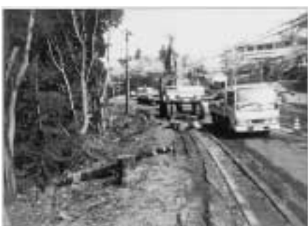
緊急経済雇用対策事業による樹木伐採修繕
