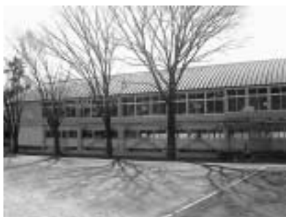
耐震化工事が完了した南小体育館
