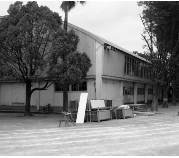
耐震補強事業を実施する南小体育館
