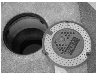
消防水利（防火水槽）
