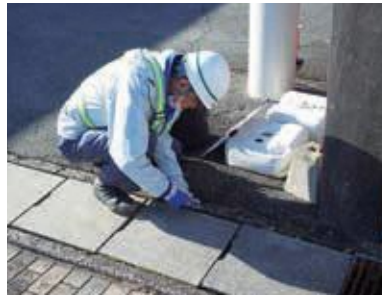
一筆地調査 境界プレート貼付
