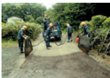
舗装道路の改修事業（ハード） 南一碧台自治町内会
