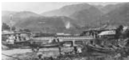
関東大震災(大正12年)の被害の様子(河口側からみた大川橋)
