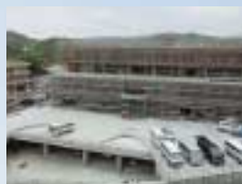
◀H24.2 本体4階まで施工
