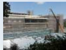
H24.8 立体駐車場工事
