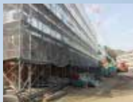
◀H23.11 本体2階まで施工
