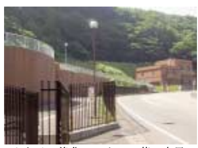
かわせみ浄化センター。荻・十足地区の下水が集められ、きれいな水へと浄化されます。
