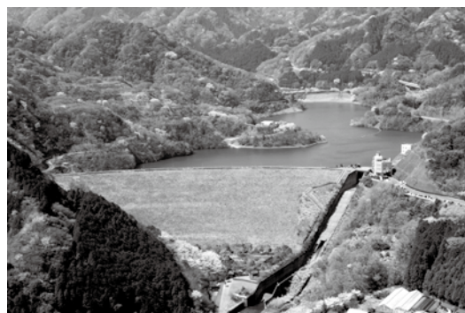
奥野ダム全景
