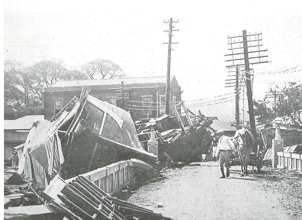
写真8 津波によって大川橋の欄干に船が乗り上げている（『関東震災畫報』から）。
