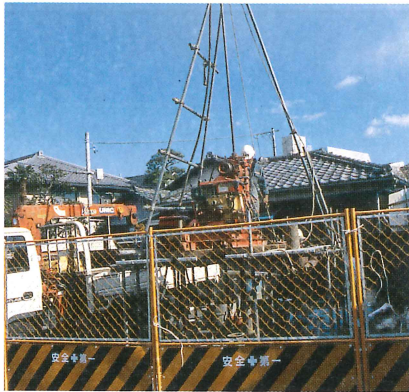
ボーリング調査の実施状況
