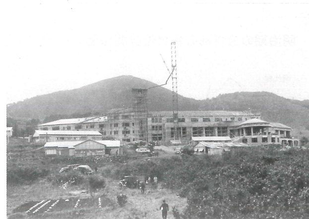
写真8 建設作業中の川奈ホテル (昭和10年撮影、東海自動車所蔵写真)
