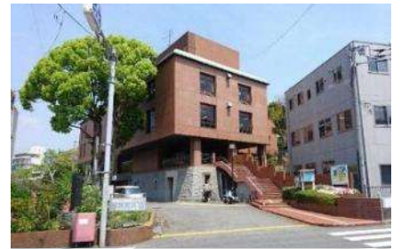
図 2-8 現図書館等外観
