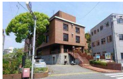
図 2-8 現図書館等外観
