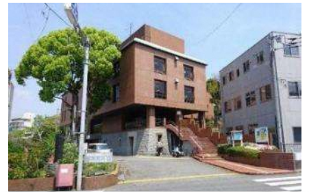
図 2-8 現図書館等外観
