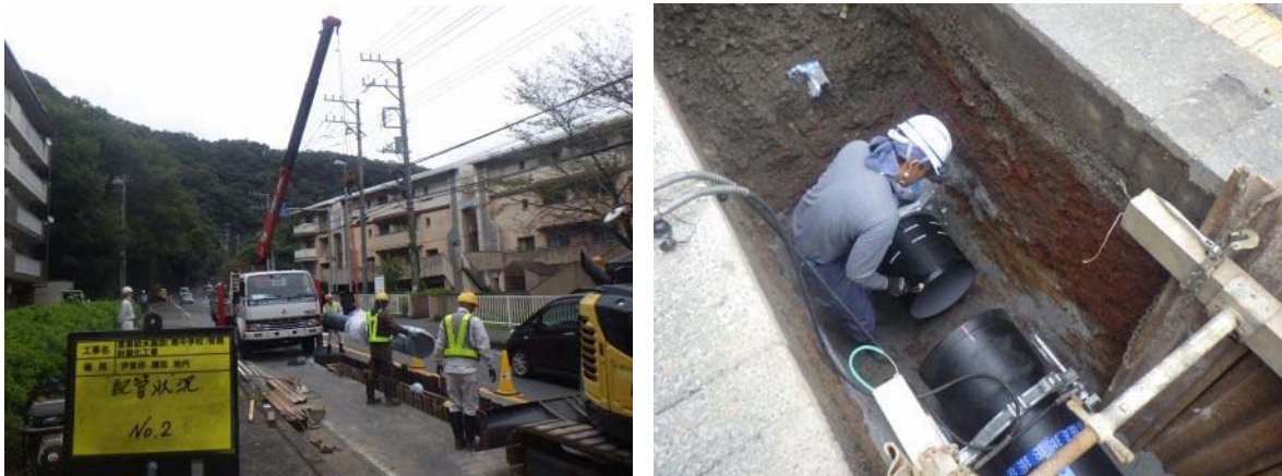
図 4.3.3 管路工事の様子
