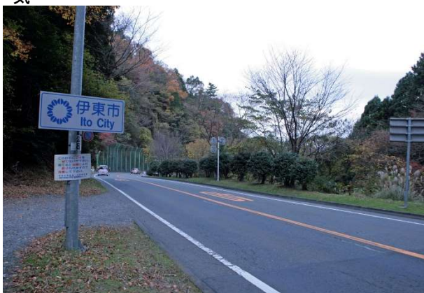
中伊豆バイパス：伊東市への入口付近
