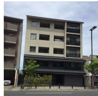
▲壁面と一体的にデザインすることで壁面の形態が美しくまとまり、すっきりと見える
