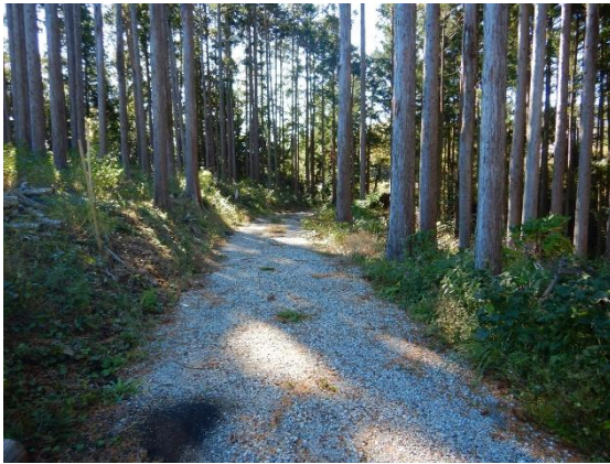
森林作業道の整備（池区）
