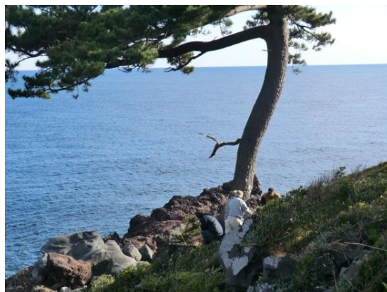
予防剤注入作業
