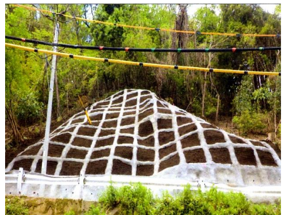
令和 2 年度復旧状況 林道八代田線
