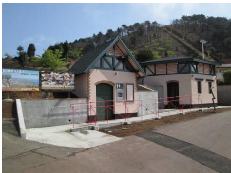
1110 PRIVY 小室外観
