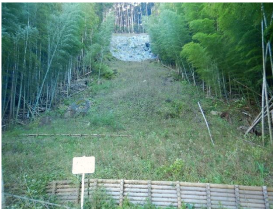
池地区県単治山（緊急）工事（完成）
