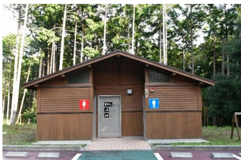
知久保の森観光トイレ 外観
