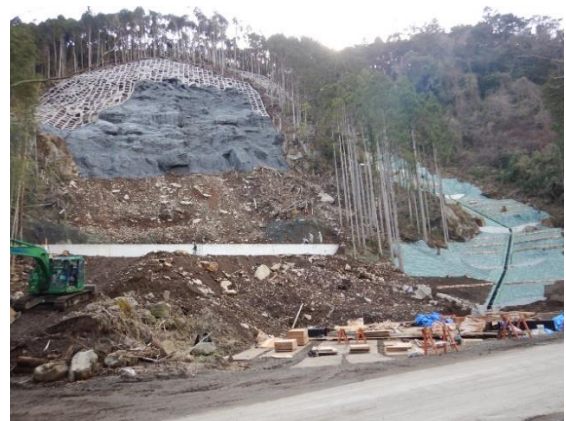
池地区治山（緊急）工事（継続中）
