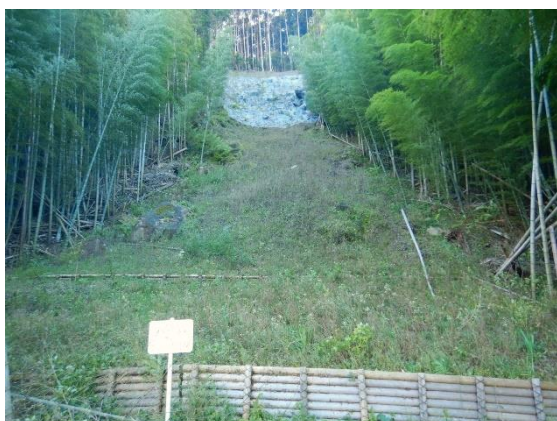
池地区県単治山（緊急）工事（完成）
