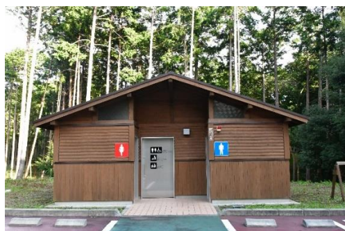
知久保の森観光トイレ 外観
