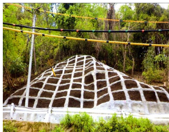
令和2年度復旧状況 林道八代田線
