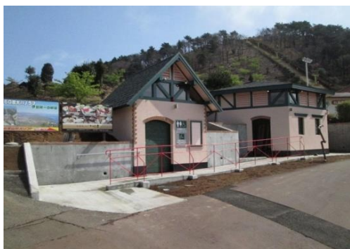
1110 PRIVY 小室外観
