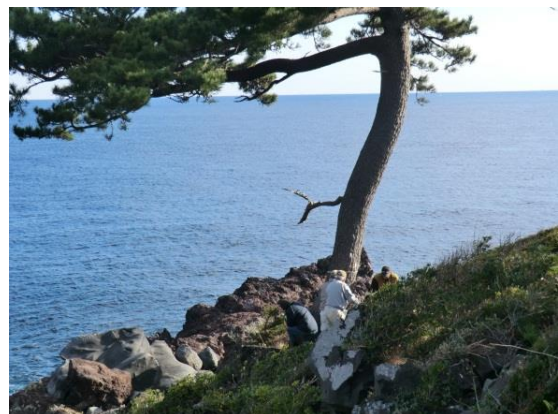
予防剤注入作業
