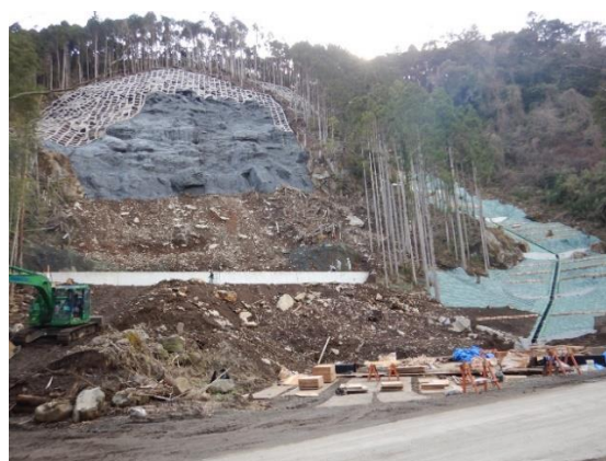
池地区治山（緊急）工事（継続中）
