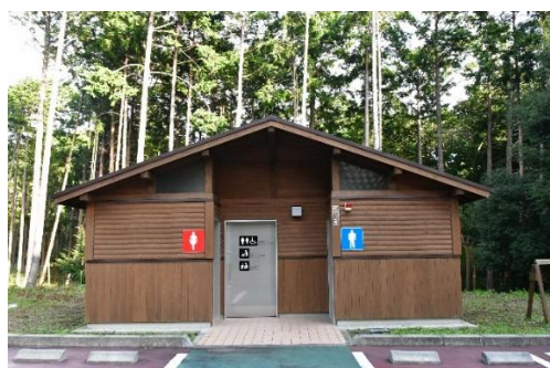
知久保の森観光トイレ 外観
