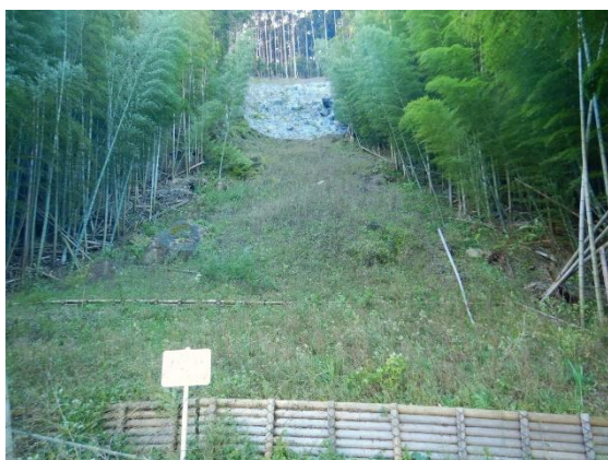
池地区県単治山（緊急）工事（完成）
