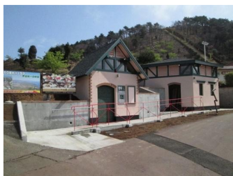
1110 PRIVY 小室外観
