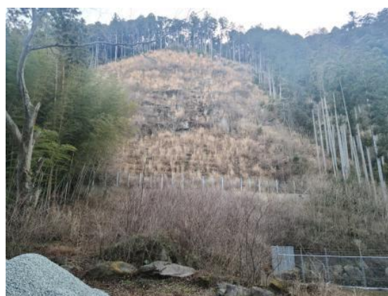
池地区治山（緊急）工事（完成）
