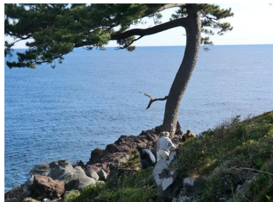
予防剤注入作業
